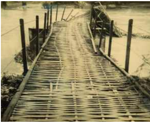
ภาพ ขัวแตะข้ามแม่น้ำวังบริเวณบ้าน ท่าผาที่ชำรุดขาดไปเนื่องจากถูกน้ำ พัดในช่วงฤดูน้ำหลาก จึงจำเป็นต้อง สะพานขัวแตะใหม่ทุกปี ที่มา : อาจารย์กนิษฐา ช้อนสุข
