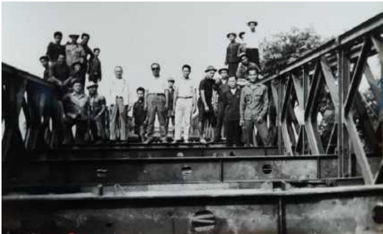
ภาพ ทีมช่างสร้างสะพานพระราชวังพุดเดถ่ายภาพภายหลังการวางโครงเหล็กแบร้งเชื่อมถึงกันทั้งสองฝั่งแต่ยังไม่ได้วางพื้นสะพาน ที่มา : อาจารย์กนิษฐา ช้อนสุข
