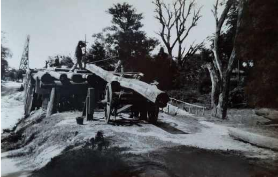
ภาพบรรยากาศการสร้างสะพานพระแก้ว ขณะที่ทีมงานก่อสร้างกำลังใช้เกวียนลากไม้ซุง มาทำโครงรับน้ำหนักโครงสร้างเหล็กตัวสะพาน โดยถ่ายจากฝั่งบ้านท่าผา ที่มา : อาจารย์กนิษฐา ช้อนสุข
