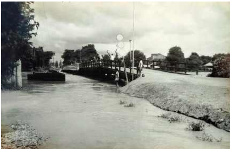
ภาพ บรรยากาศสะพานประชารัฐพงเดชในฤดูน้ำหลาก ถ่ายจากบริเวณฝั่งที่ว่าการอำเภอ ในภาพยังคงปรากฏต้นไม้สามเหลี่ยมใช้กันเศษวัชพืชหรือต้นไม้ที่ไหลมาตามกระแสน้ำเพื่อ เบี่ยงให้ตะกอนเหล่านั้นลอดใต้สะพานได้สะดวกและไม่เกิดความเสียหายต่อสะพานแข็ง ที่มา : อาจารย์กนิษฐา ช้อนสุข
