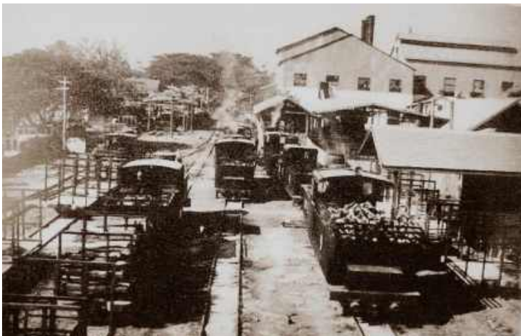
ภาพบรรยากาศภายในโรงงานน้ำตาลไทยลำปางถ่ายจากประตูลำเลียงอ้อยด้านทิศตะวันออก โดยในภาพด้านขวามือปรากฏตู้รถไฟที่ใช้ลำเลียงฟืนที่ใช้สำหรับเป็นเชื้อเพลิงในการขับเคลื่อน เครื่องจักรไอน้ำ ที่มา : เทศบาลตำบลท่าผา
