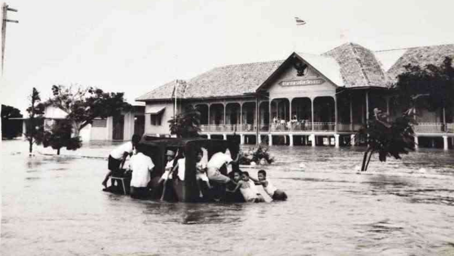
ศาลากลางจังหวัดระยอง ตั้งอยู่ริมถนนตากสินมหาราช ในคราวน้ำท่วมเมื่อวันที่ ๖ ตุลาคม พ.ศ. ๒๕๐๓ (ภาพจากนางสุวรรณณี จรุงวงศ์เสถียร)
